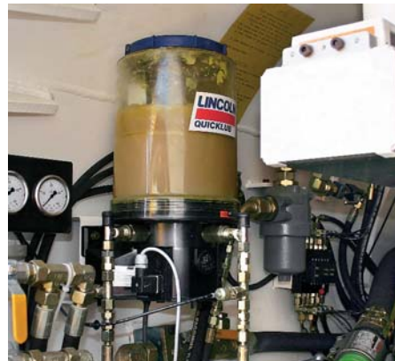
Проходческий комплекс оснащен ЦСС
